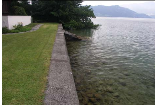
Ufersituation Transekt 10 (Blick Richtung Südosten).
