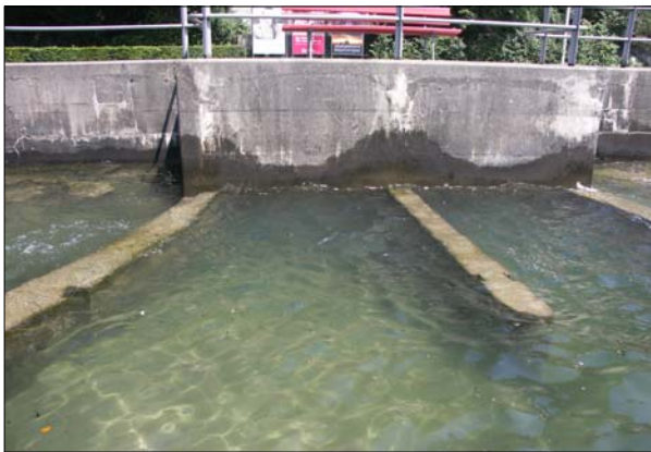
Detailansicht des Einleitungsbauwerkes mit den 3 seeseitigen Leitmauern.
