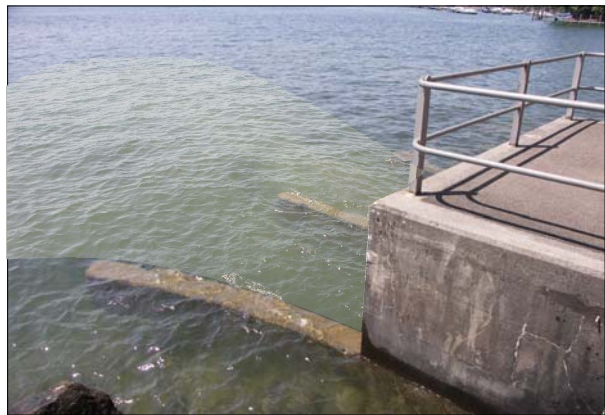
Einleitbauwerk mit grösserer Vegetationsloser Fläche vor der Mündung (Fläche ungefähr nachgezeichnet).
